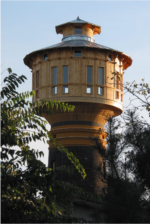
Fig. 8. Reused water tower of Gyáli út, 2005.
