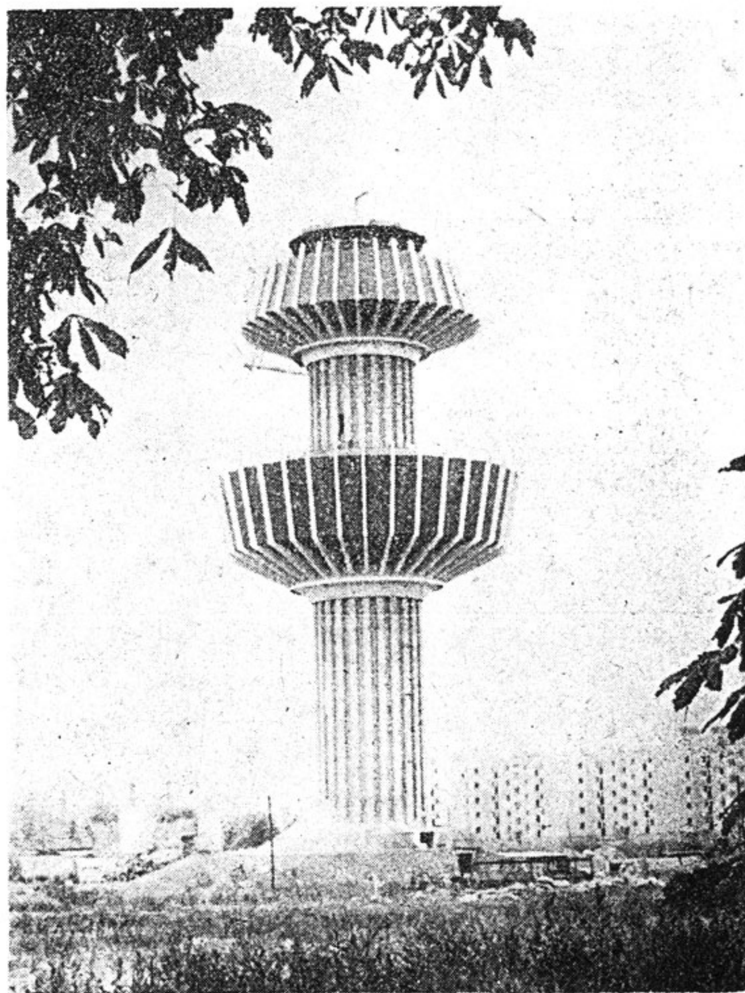
4. kép. A megvalósult 6000 m 3 -es víztorony Bild 4. Der 6000 m 3 fassende fertige Wasserturm
